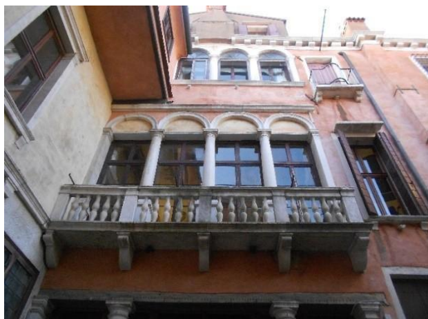
Facciate lato terra
